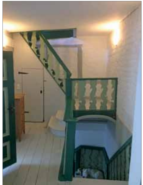
Treppenaufgang mit Einhausung und Tür des Wohnungseingangs im Obergeschoss vor und nach dem Rückbau bzw. der Treppentreilegung. Alle Fotos: Carola u. Christoph Rudnick
