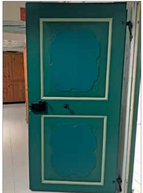
Zweifüllungstür mit Zierfüllungen aus dem 17. Jahrhundert vor und nach der Restaurierung
