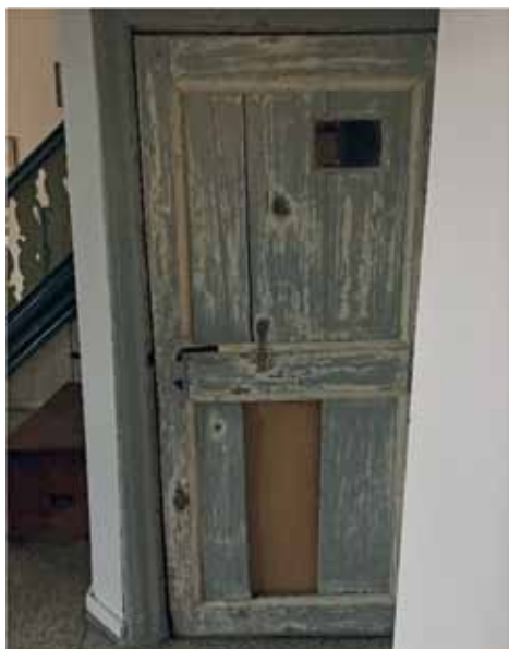
Zweifüllungstür aus dem 16. Jh. während und nach der Restaurierung
