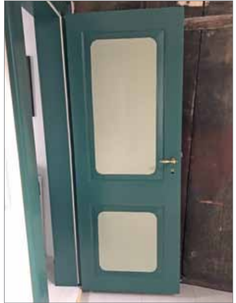
Wiedereingebaute Zweifüllungstür aus dem 18. Jahrhundert (1788) im Erstanstrich mit rekonstruierten Zargen während und nach der Restaurierung
