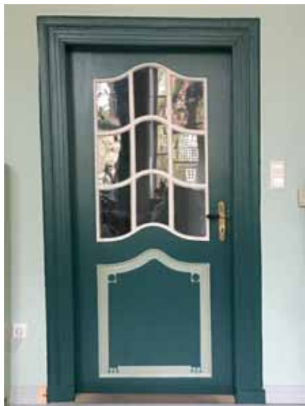
Eine der zwei Rahmen-Füllungstüren des 18. Jahrhunderts (1788) mit geschweiftem Sprossenfenster während und nach der Restaurierung
