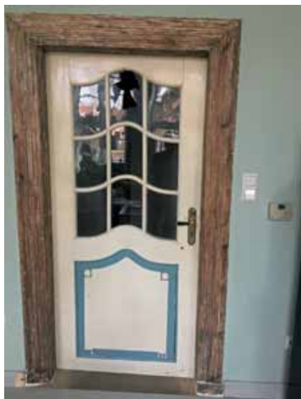
Eine der zwei Rahmen-Füllungstüren des 18. Jahrhunderts (1788) mit geschweiftem Sprossenfenster während und nach der Restaurierung
