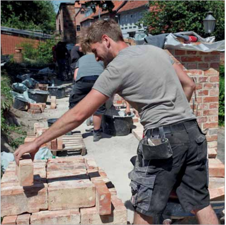
Maurer-Lehrlinge, Freiwillige der Jugendbauhütte im Landkreis Stade und Schüler der Georg-Sonnin-Schule (Berufsbildende Schulen II) waren im Einsatz für den Denkmalschutz. Pfeiler und Felder wurden getrennt gemauert und mit rostfreien Flachverbindungen verbunden. Foto: Werner Waschke, Juni 2018
