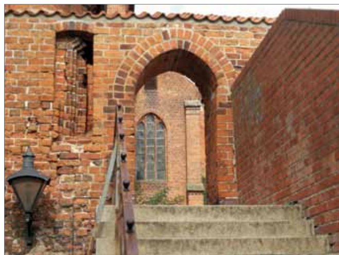
Abb. 7 Links der Türgewänderest einer alten Schneiderpforte, rechts die jetzige Schneiderpforte. Foto 2018
