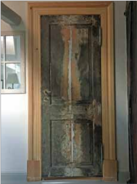
Wiedereingebaute Zweifüllungstür aus dem 18. Jahrhundert (1788) im Erstanstrich mit rekonstruierten Zargen während und nach der Restaurierung
