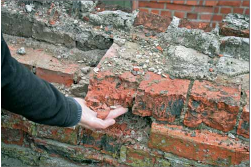
Die ungleichmäßig gebrannten Ziegel zerbröseln. November 2016
