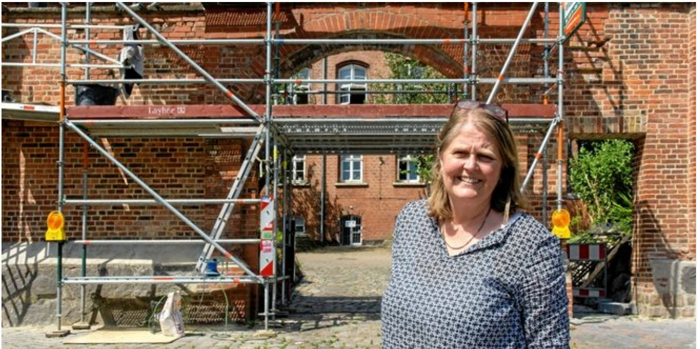
Dörthe Grimm zeigt, wo die Handwerker sozusagen mehr Platz schaffen: Das Tor der Herberge wird erhöht. (Foto: t&w)
